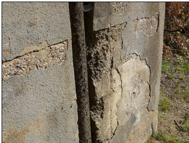
4. O 01 – degradace betonu v okolí odpadního svodu vlevo
